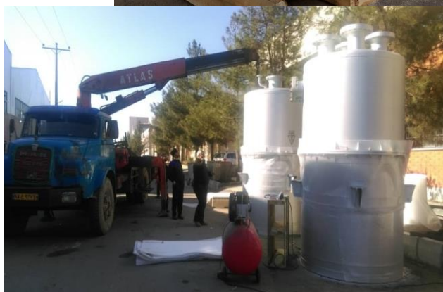
دو سایلنسر ونت بخار پتروشیمی متانول آرتا
